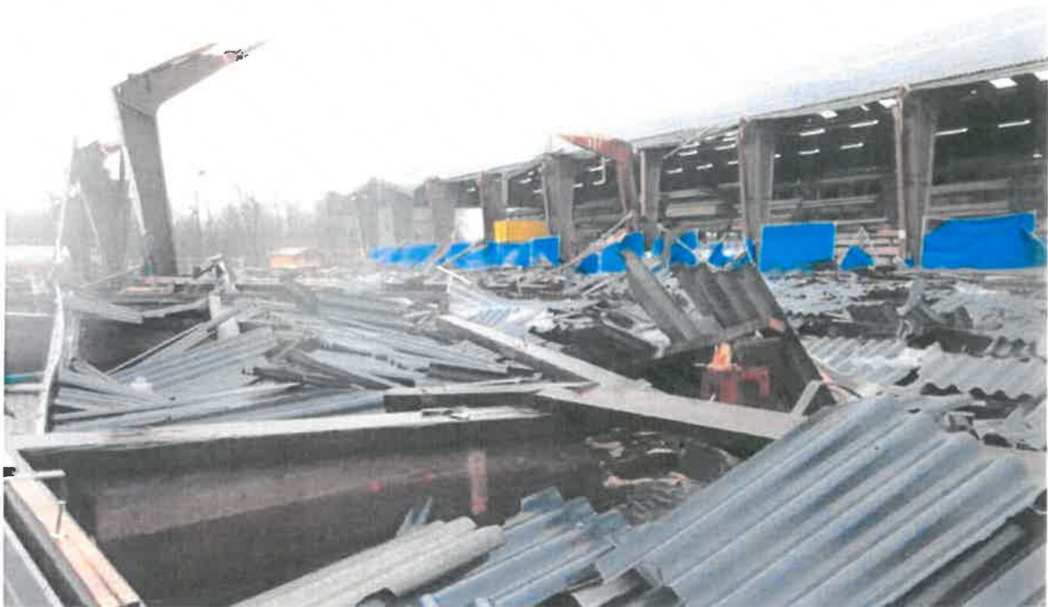
Foto: Na een hevige sneeuwbuï bleek deze constructie niet sterk genoeg om het gewicht van de sneeuw te kunnen dragen.
